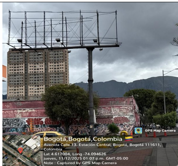
Fotografía No. 2 – Vista de la estructura de la valla sin el panel publicitario instalado.
